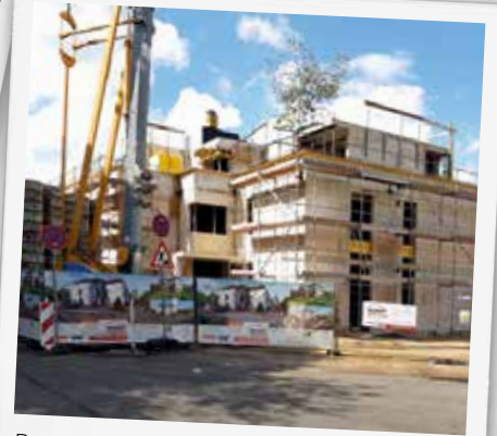
Besonders stolz war Geschäftsführer Werner Mundt, dass trotz des schlechten Baugrundes und der schwierigen Grundwasserverhältnisse alle Termine eingehalten wurden.
